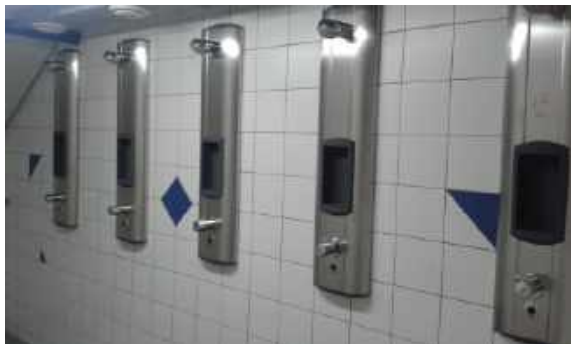
Beide Duschräume wurden neu gefliest und mit neuen Armaturen ausgestattet
